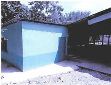
Foto 3: Remodelación de Cocina
