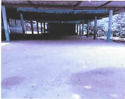
Foto 1: Sustrucción de Torta de cemento
