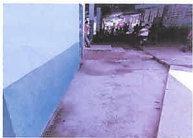
Foto 5: Sustrucción de banqueta
